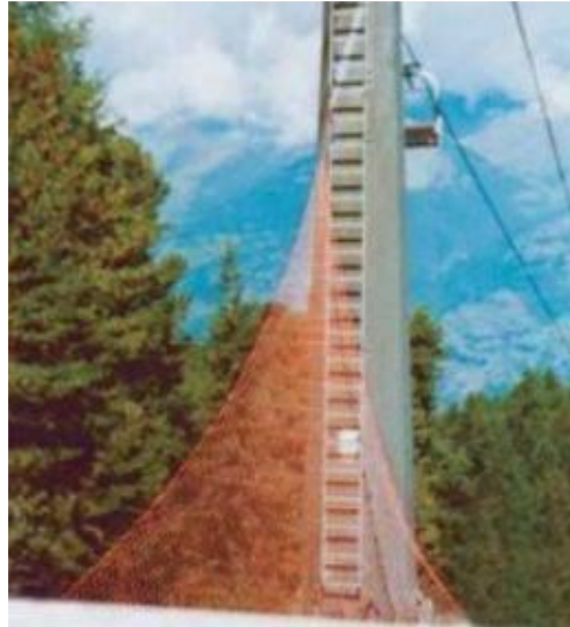
Trikotna mreža, ki se običajno namešča pred stebre žičniških naprav
